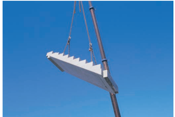
Bild 10: Beton-Fertigteiltreppe am Montagekran
