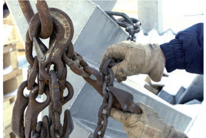
Bild 4: Anlegen des Montagegehänges
