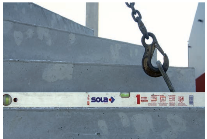
Bild 12: Stufen müssen quer zur Laufrichtung waagrecht liegen
