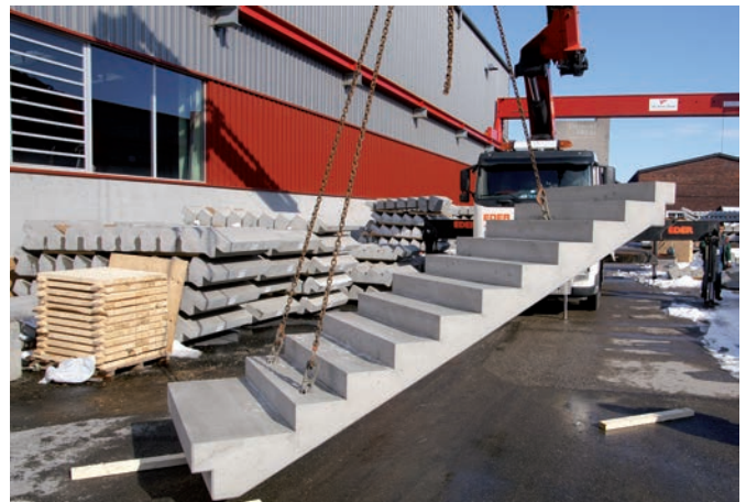
Bild 8: Einheben einer Beton-Fertigteiltreppe
