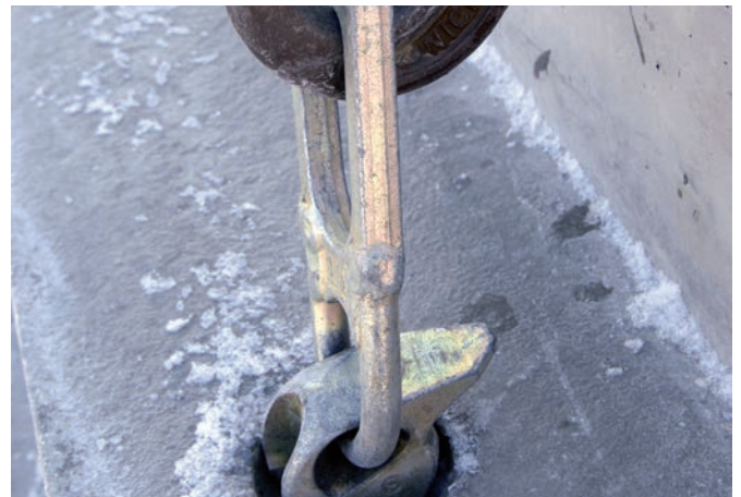
Bild 5: Anschlagen der Treppe am Transportanker
