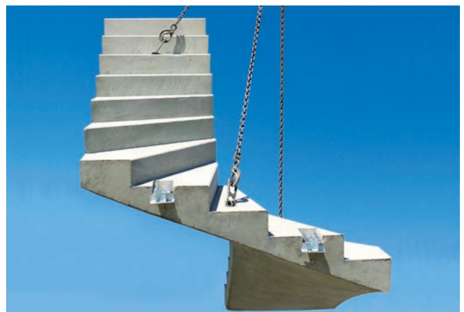
Bild 9: Treppe am Kran im Montagelage
