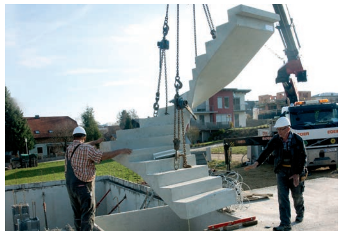
Bild 11: Einheben der Treppe in Montagelage
