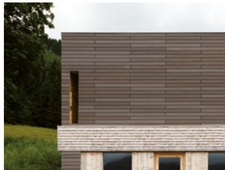
öko skin 147 mm, silvergrey, pose verticale (décalage 1/3), vis sur ossature bois
