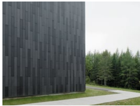
öko skin flex 125 mm, couleurs diverses, pose verticale, vis sur ossature bois
