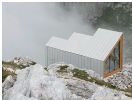
öko skin flex 147 mm, couleurs diverses, pose verticale, rivets sur ossature en aluminium
